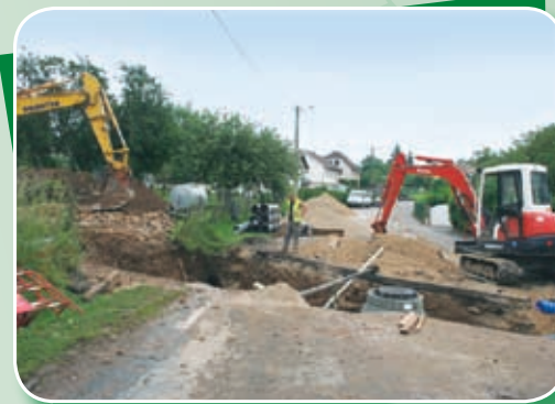
Tranchée avenue de la Gare
