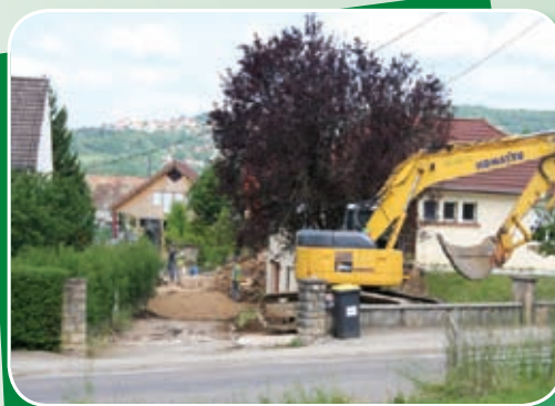
Travaux chez un riverain
